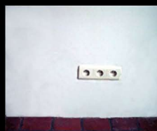
Mur après traitement
