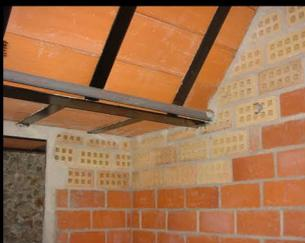
Des aérations naturelles hautes et basses sont mises en place par des conduits rigides rectangulaires de 20x30, les aérations existantes sont élargies et le renouvellement de l'air est amplifié par un extracteur électrique permanent relié au tableau des services généraux.
