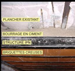
Une solution couramment adoptée consiste à mettre en place une structure indépendante par IPN qui permet de soutenir la structure existante par le sous-sol.
