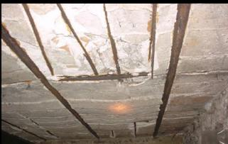
Les caves mal ventilées (sopiraux bouchés suite à des travaux d'aménagements de magasins par exemple...) et subissant des infiltrations d'eau provenant des terres saturées de remblais et des terres sous fondations, sont généralement le siège de phénomènes de condensation sur tous les thermiques,
